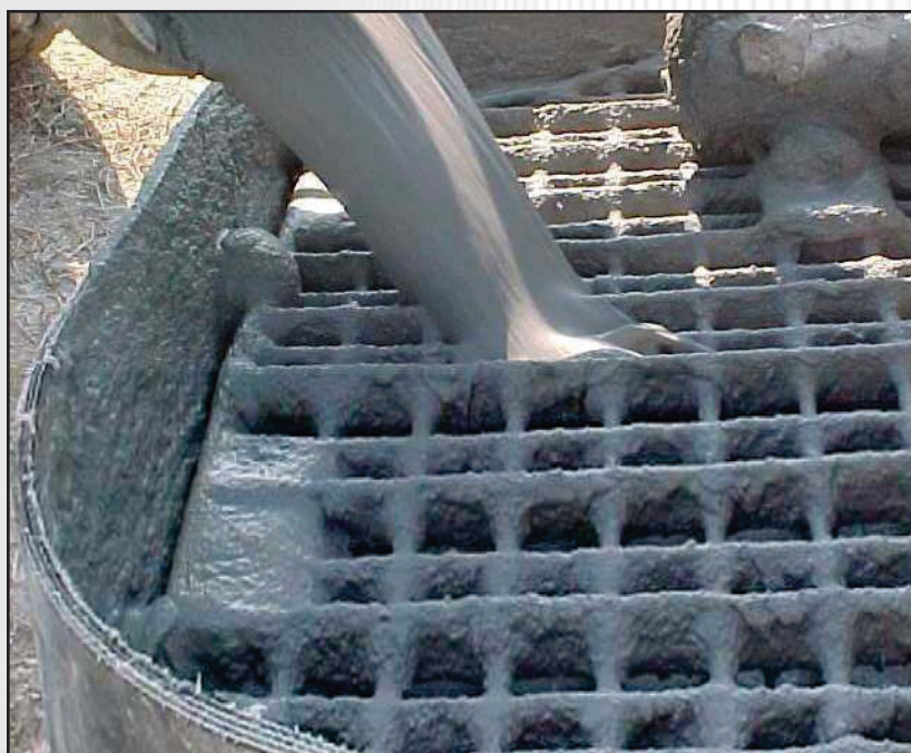
Coulis léger à écoulement fluide Résistance à la compression 1380 kPa (200 lb/po 2 )
