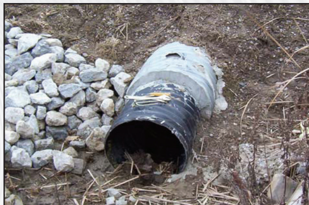
TTO de garnissage à strate de polymère recouvert de coulis
