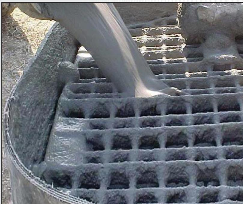
Coulis léger à écoulement fluide Résistance à la compression 1380 kPa (200 lb/po<sup>2</sup>)
