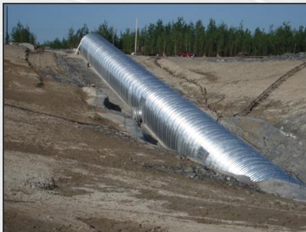
ARGILE DU TERRAIN DE RECOUVREMENT RETIRÉE POUR PERMETTRE L'INSTALLATION DU PORTAIL EN TÔLE FORTE À ONDULATIONS PROFONDES DE 6320 MM DE PORTÉE, DE 5630 MM D'ÉLÉVATION ET DE 162 M DE LONG
