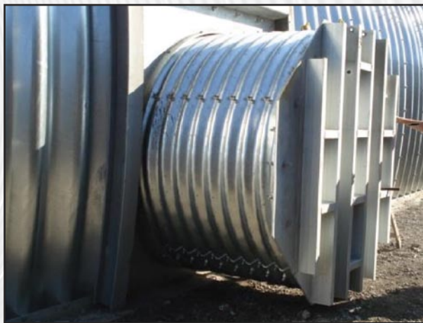
STATION DE SÉCURITÉ POUR TROIS PERSONNES EN TUYAU DE TÔLE FORTE EN ACIER ONDULÉ DE 2120 MM DE DIAMÈTRE AVEC CLOISON RENFORCÉE ET PROFILÉS DE RENFORT
