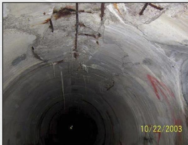
TUYAU D'ÉGOUT RIGIDE FISSURÉ ET CORRODÉ
