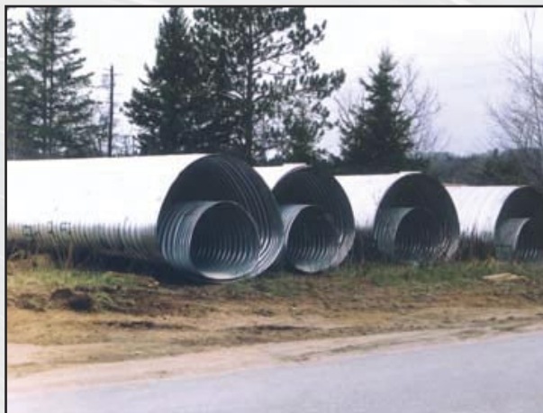
PRÊTS À ÊTRE INSTALLÉS SUR LES LIEUX PETIT VOYAGE POUR DES TUYAUX IMBRIQUÉS LES UNS DANS LES AUTRES
