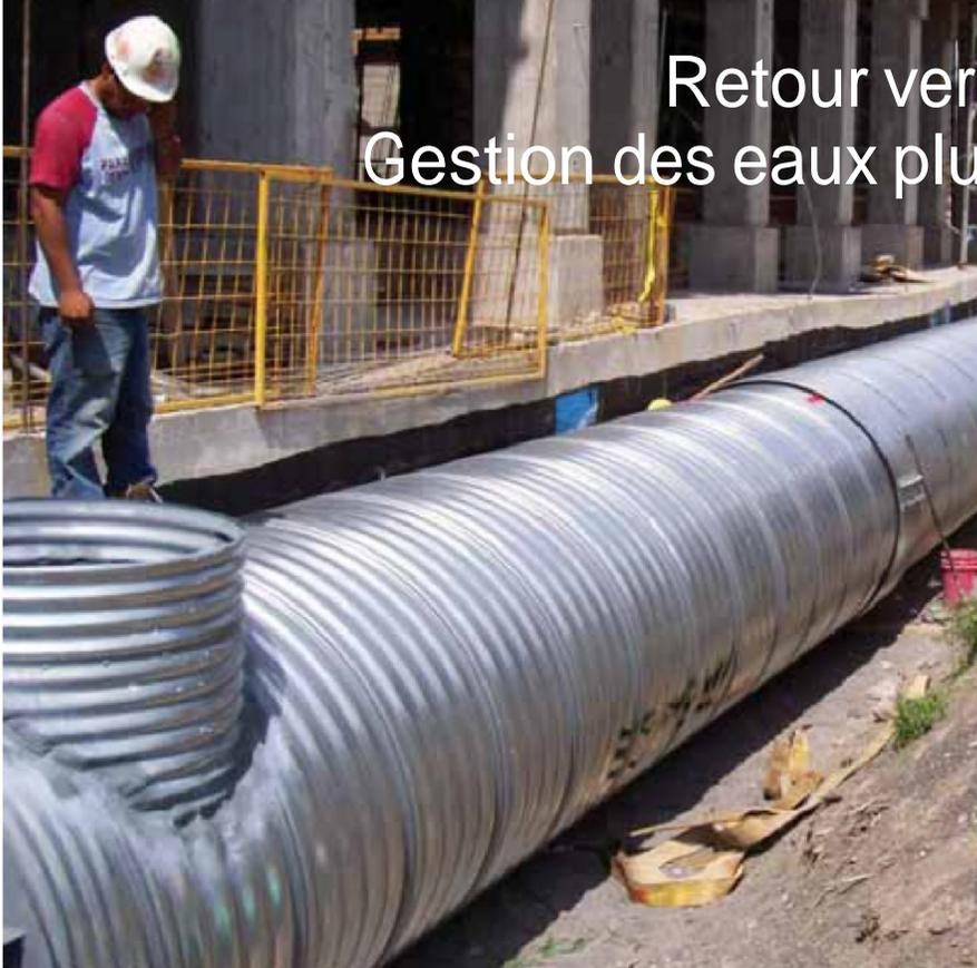
Réservoir en TTO de rétention des eaux pluviales de 1700 mm de diamètre sous One Park Tower.
